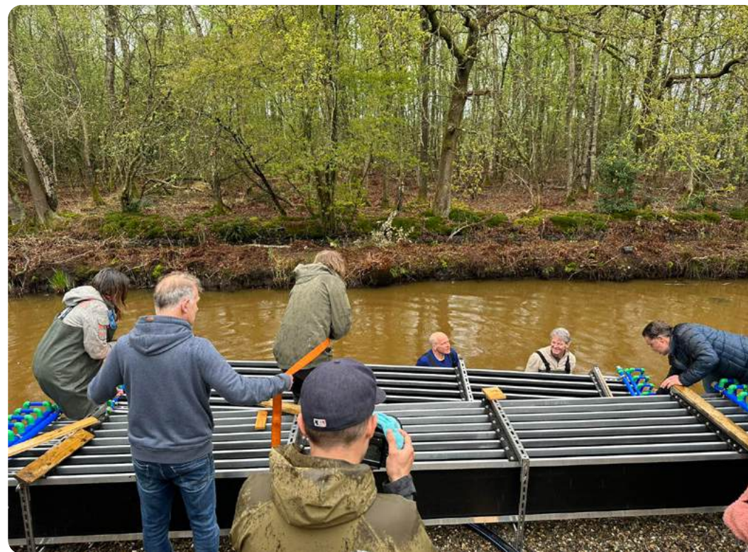
Plaatsing van de warmtewisselaars in een sloot bij een mini-warmtenet in Soest
