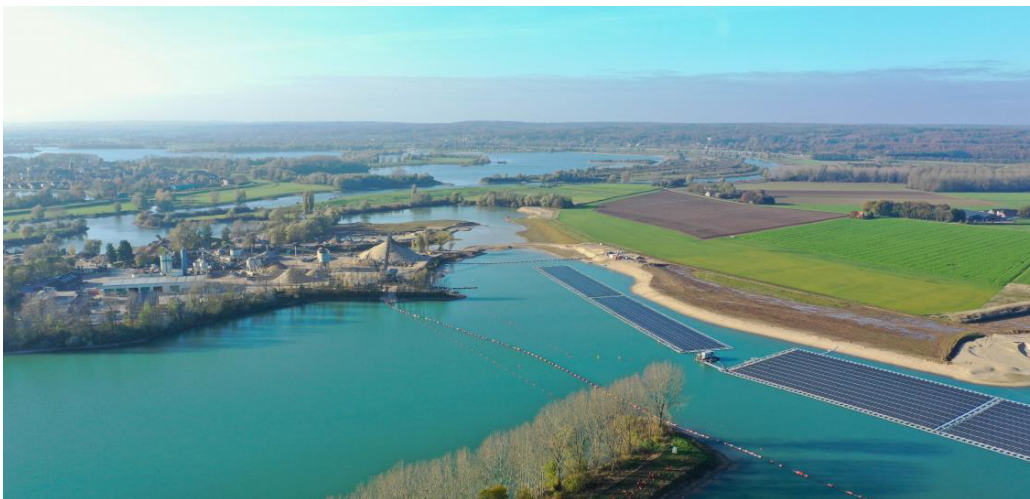
Drijvende zonnepanelen leveren de energie voor zandwinning in de Havikerwaard bij Rheden (foto: K3Delta)
