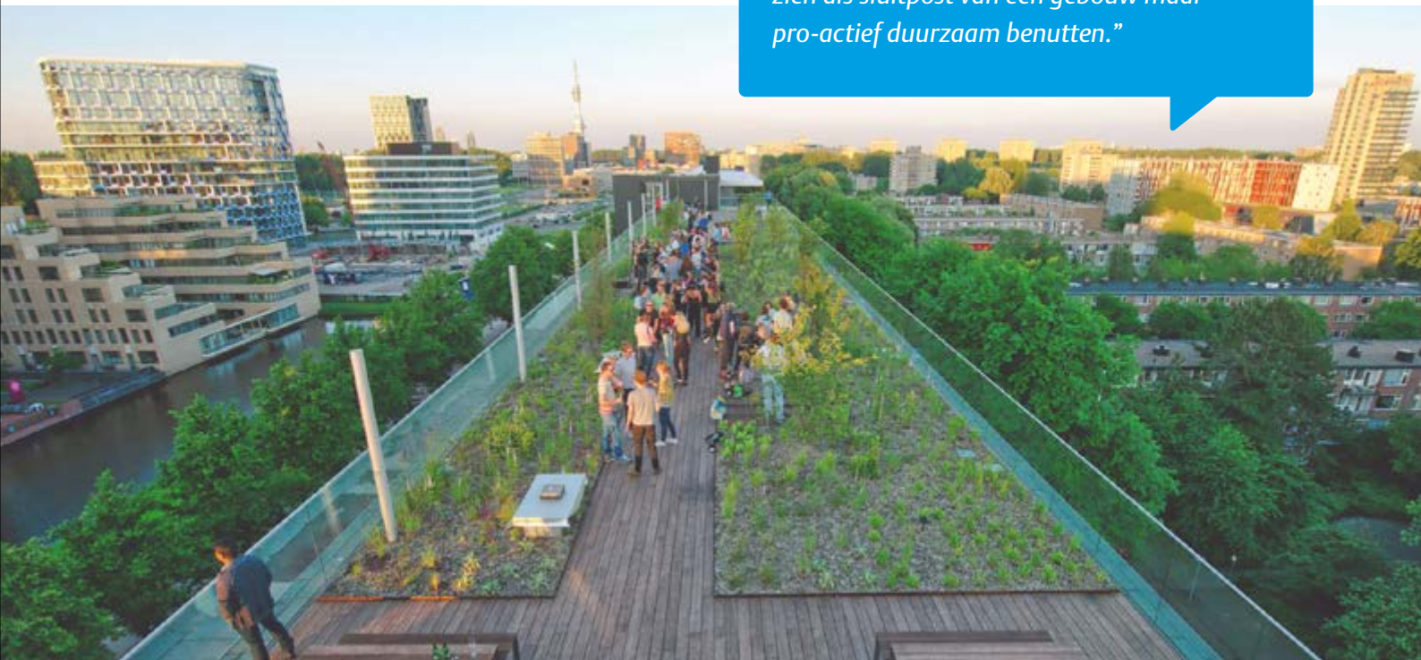
Gebouw De Boel aan de Boelelaan in Amsterdam. Daktuin voor huurders van het gebouw, gebouwd op een polderdak. Zie https://dakdokters.nl/portfolio-items/boelelaan/
